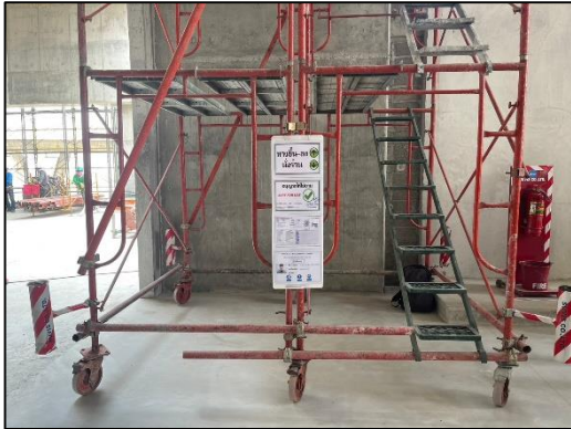
ภาพที่ 129 การตรวจสอบความปลอดภัยของนั่งร้าน
