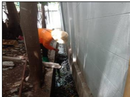
ภาพที่ 52 กิจกรรมขุดลอกตะกอนดิน
