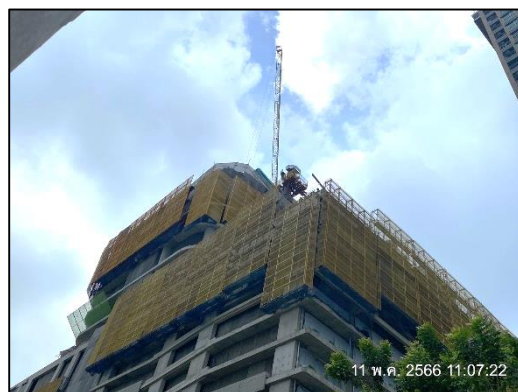
ภาพที่ 4 วัสดุป้องกันการตกหล่น
