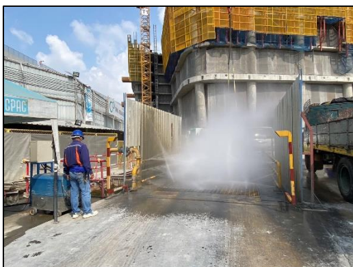
ภาพที่ 23 กิจกรรมฉีดล้างล้อรถบรรทุก
