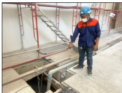
ภาพที่ 56 เจ้าหน้าที่ตรวจสอบจุดรั่วซึมของท่อระบายน้ำ
