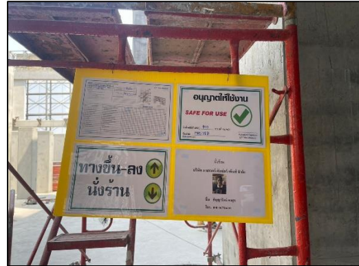
ภาพที่ 129 การตรวจสอบความปลอดภัยของนั่งร้าน
